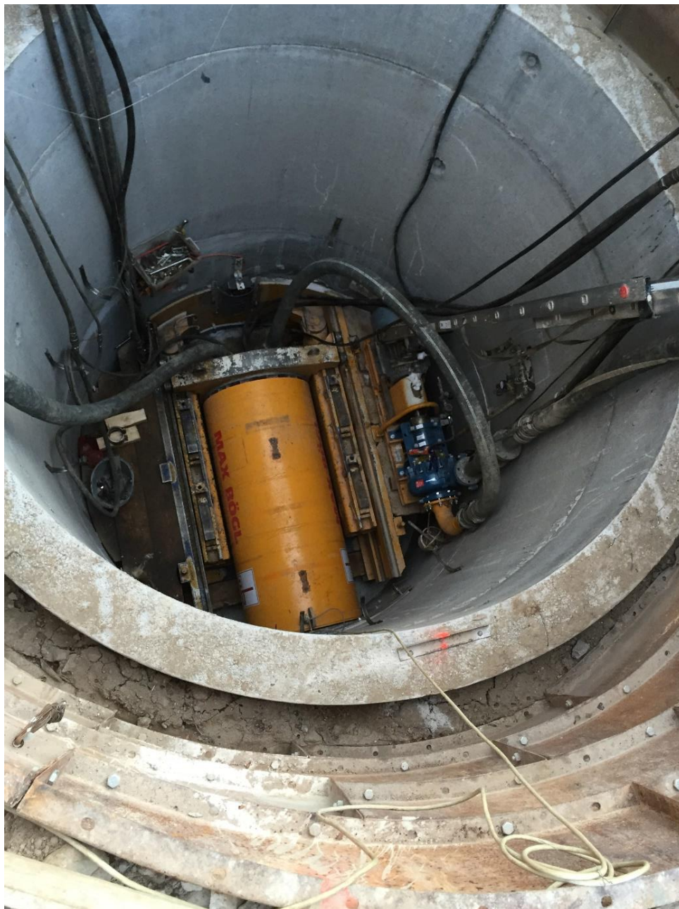
Figura 9-H : Cantiere microtunnelling pozzo di spinta
